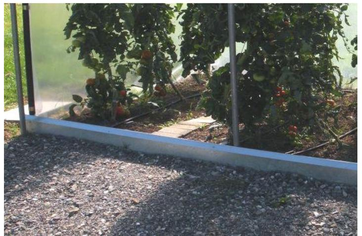
Ensuite, les deux tubes de guidage de la ventilation avant sont insérés dans le sol, chacun avant le premier et le dernier arc du tunnel, 5 cm avant l'arc et 30 cm de profondeur.
