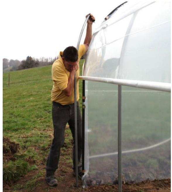
Le tube de guidage est ensuite fixé au profil de serrage avec un porte bague. A cet effet, un écrou est inséré latéralement dans le profil de serrage avant que le film ne soit tiré. Avec le couteau, vous pouvez couper une fente dans la feuille où la vis sans tête doit dépasser.
