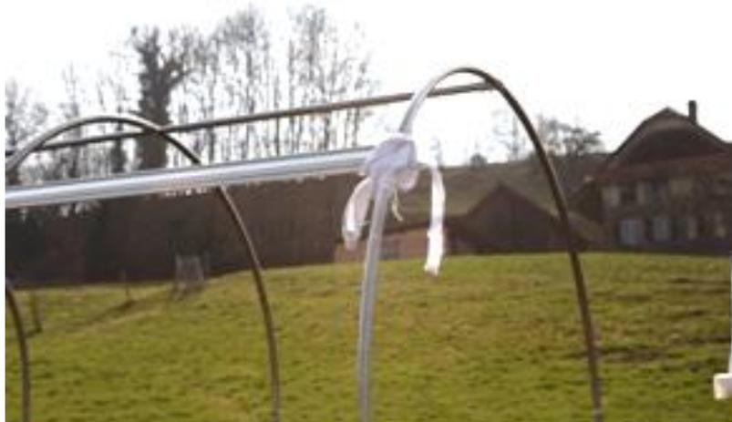
Tout d'abord, les feuilles (article 9) des deux parties latérales sont étirées et fixées avec des profils de serrage en plastique. Les pièces en PVC (article 12) sont utilisées dans la zone de la voûte, les longs profils en plastique (article 10) sur les jambes
