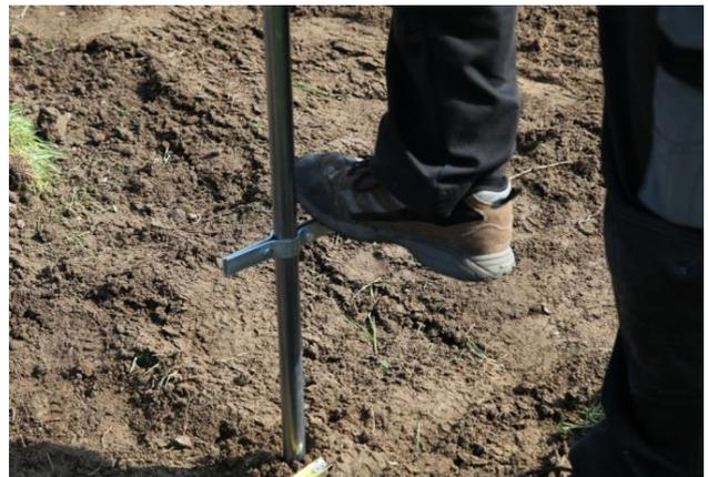
Maintenant, le connecteur longitudinal (article 3) est installé dans la crête. Une bride en T est installée à chaque extrémité. (Pos. 3.1 - 3.3)
