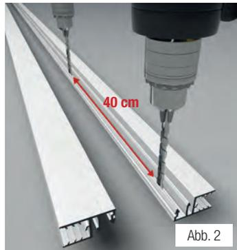
2. Die Zevener Sprosse **3** wird auf die Längsseiten der vorbereiteten Stegplatten **6** aufgestülpt. Beachten Sie bitte dabei, dass die Platte 5 mm Abstand (Abb. 1) zum Verlegeprofil behält. Achten Sie darauf, dass das Profil seitenverkehrt mit der gegenüberliegenden Seite aufgedrückt wird, damit Sie später die Profile ineinander „klippen“ können. Die Platten müssen unbedingt mit der UV-geschützten Seite nach oben verlegt werden. **(Polycarbonat hat einen einseitigen UV-Schutz)**
