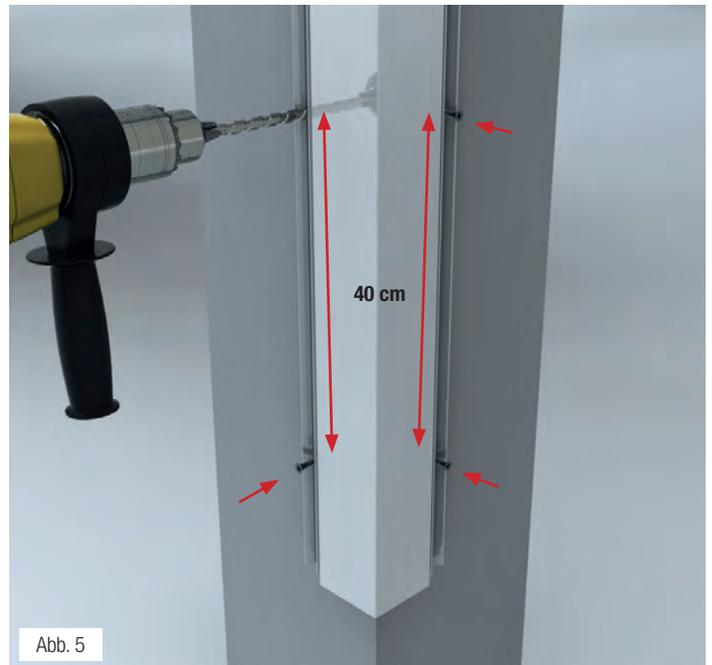
5. Bei der Montage des Zevener Eckprofils 4 muss ebenfalls auf das gesonderte Achsmaß geachtet werden. Bitte bohren Sie alle 40 cm mit einem 5-mm-Bohrer vor (Abb. 5) und befestigen Sie das Zevener Eckprofil mit einer 4,2 x 32 mm A2 Kreuzschlitzschraube.
